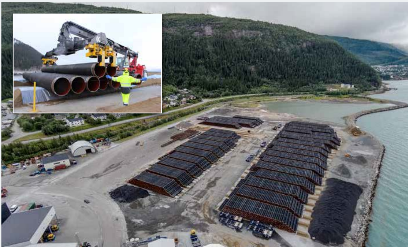
Wasco Coating Norway i Mo i Rana armerer og behandler 40.000 rør som benyttes i Åsta Hansteen-utbyggingen.
