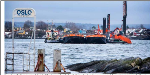
Sprengningen i Oslofjorden har vært lokal motstand i flere kommuner langs fjorden. Arbeidet har allerede startet, men grunnene med aller størst konsentrasjon av miljøgifter skal etter planen sprenges nå i Heleset. Se video av sprengningen på www.youtube.com/watch?v=U3HAR2D8E2U .
