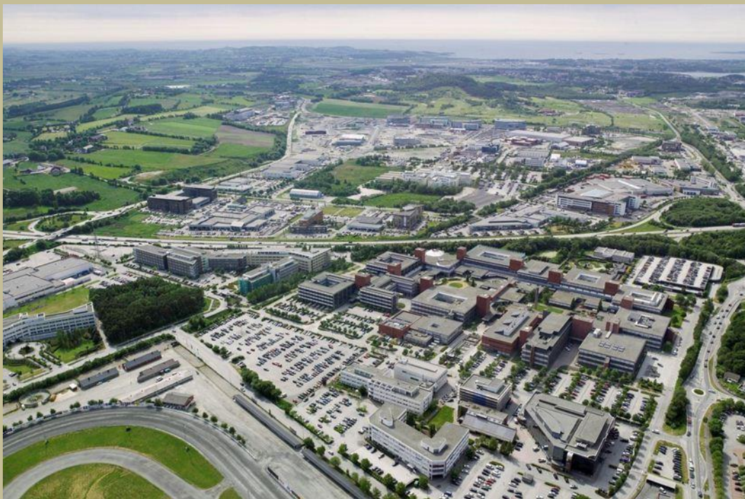
Forus ligger på begge sidene av motorveien Stavanger-Sandnes og kan deles i fire deler (nordvest, nordøst, sørvest og sørøst), bildet viser deler av Forus sørøst og sørvest med Statoils hovedbygg midt i bildet. Bilde: Forus næringspark AS
