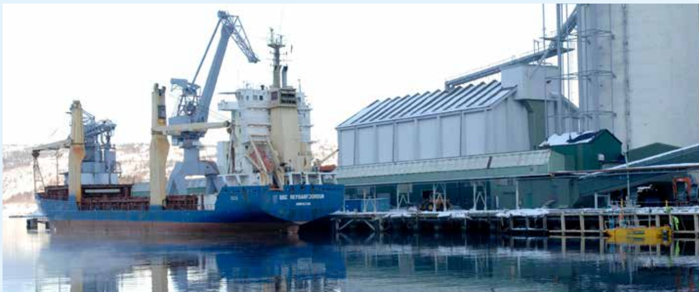
Nordland har en omfattende industrieksport. Her fra Alcoas anlegg i Mosjøen.
